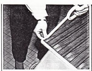
Der Holzboden muß ebenfalls sorgfältig abgeklebt werden. Das Klebeband kräftig andrücken, damit kein Sikaflex zwischen Holz und Klebeband dringen kann.
