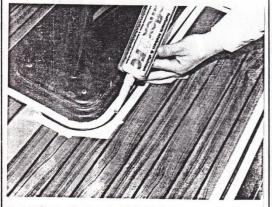
Nach 24 Stunden Trockenzeit wird die Sikaflex-Kartusche mit einer neuen Spitze versehen, die schräg geschnitten und nur eine 2-3 mm große Öffnung hat. Die Kartusche wird durch die Naht geführt. Dabei sollte darauf geachtet werden, daß sich Sikaflex ganz in die Nut hineindrückt und keine Luftblasen entstehen.
