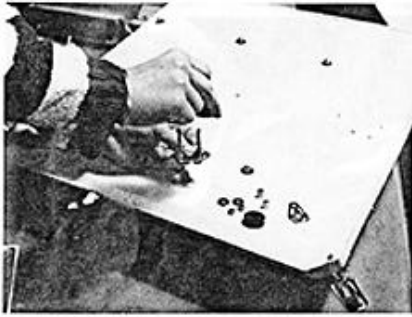
Doppelblock zusammenstecken und darauf achten das Mittel- und Außenbleche richtig montiert werden
